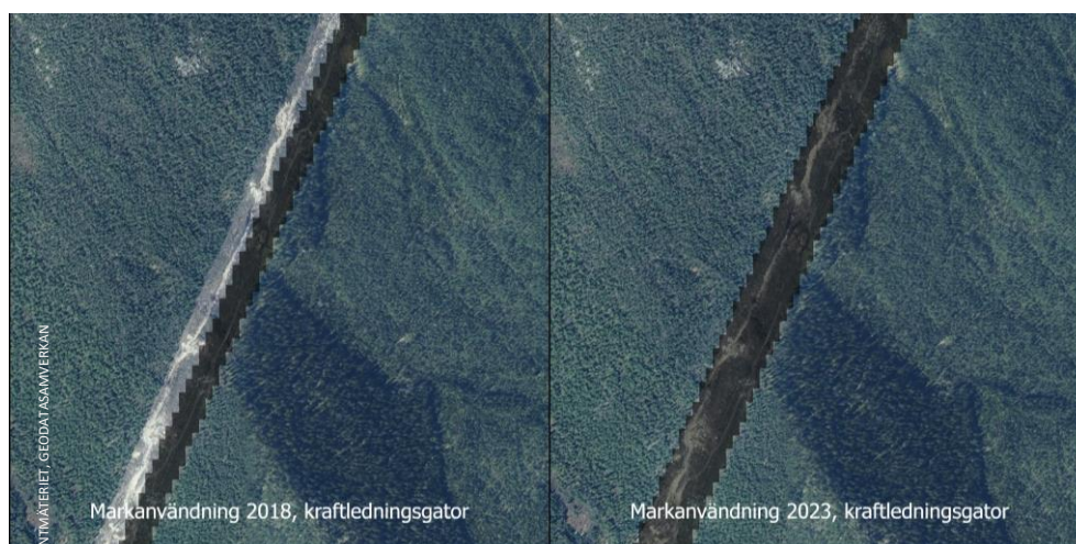
Figur 5. Jämförelse av yta från skiktet "kraftledning" som överlagrar ett ortofoto från 2021, markanvändning 2018 (vänster) och markanvändning 2023 (höger). En stor del av nytillkomna ytor utgörs av breddningar av befintliga ledningsgator där två kraftledningar nu går parallellt. Koordinat: 656 368, 7 103 443.
