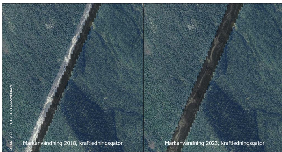
Figur 7. Jämförelse av yta från skiktet "kraftledning" som överlagrar ett ortofoto från 2021, markanvändning 2018 (vänster) och markanvändning 2023 (höger). En stor del av nytillkomna ytor utgörs av breddningar av befintliga ledningsgator där två kraftledningar nu går parallellt. Koordinat: 656 368, 7 103 443.
