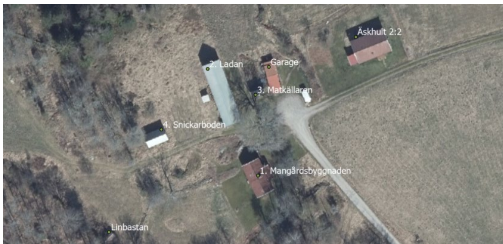
Fig. 18. Bebyggelsen i Lilla Äskhult, från utredningen framtagen av Kungsbacka kommun 2023. Äskhult 2:2 utgörs av sommarstugan som inte ligger i reservatet. Garaget är en enkel konstruktion i mycket dåligt skick. Den kommer att rivas så snart som möjligt.
