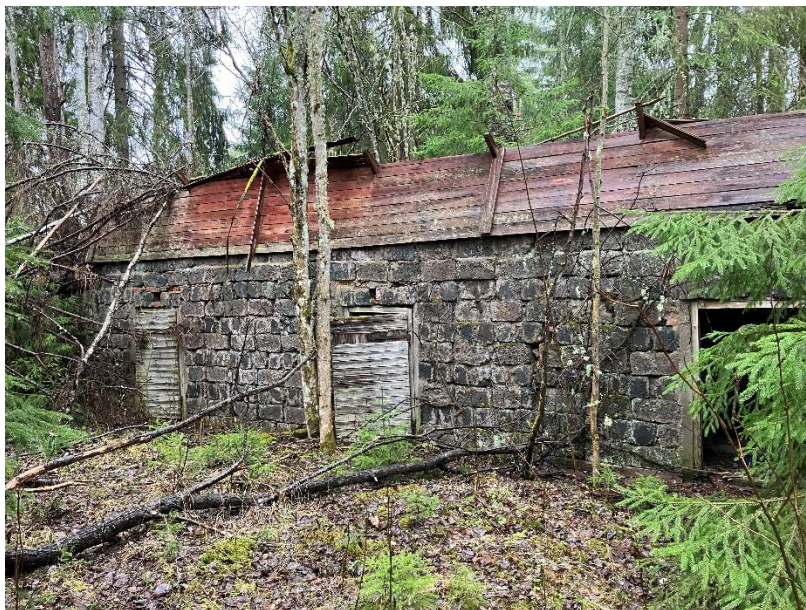
Figur 5. Äldre ekonomibygnad där de nedre delarna utgörs av jordkällare uppmurade med slaggsten.
