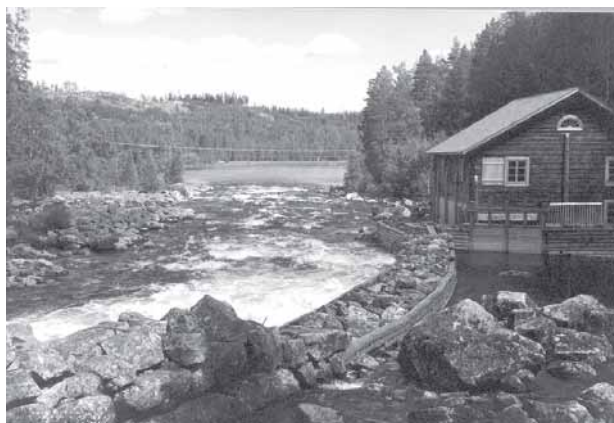
Kvarnhuset vid Sör-strömmen, Haverö strömmar
