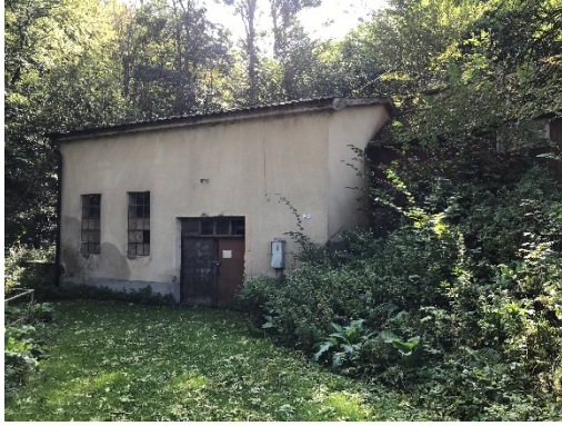
Figur 43 Turbinhuset vid Mjölmsjön
