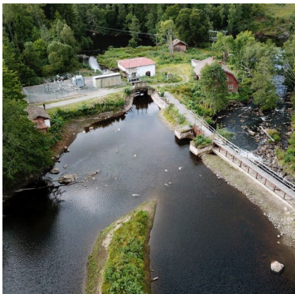
Figur 4. Dammen och byggnaderna vid Holmen innan dammen och flera av byggnaderna revs 2017. Foto: Johan Lind, Watermark.
