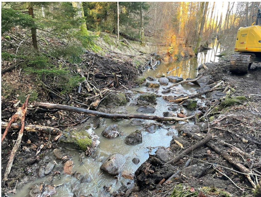
Figur 13. Exempel på upptröskling med naturmaterial likt den som föreslås längst norrut där mossens dike mynnar mot boren.
