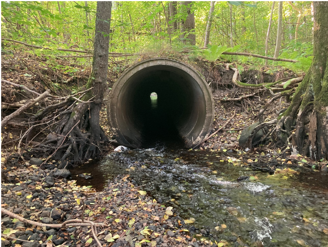
På en sträcka av cirka 60 meter rinner Pjältån genom en betongkulvert som ska tas bort.
