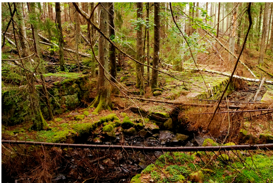
Bild 1. I södra delen av reservatet finns omfattande lämningar av Älsebo såg. Stensatta murar och rännor.
