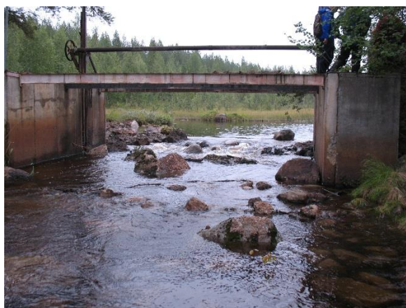
Återställd botten vid dammanläggning
