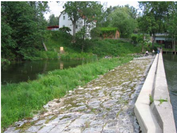
Utloppsdammen vid Sibro
