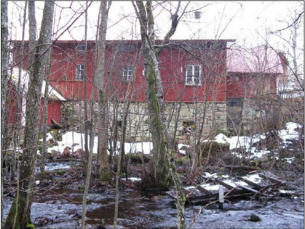
Kvarnbyggnaden med öppningarna där hjulaxlarna gick in. FOTO: Eva Klotz.
