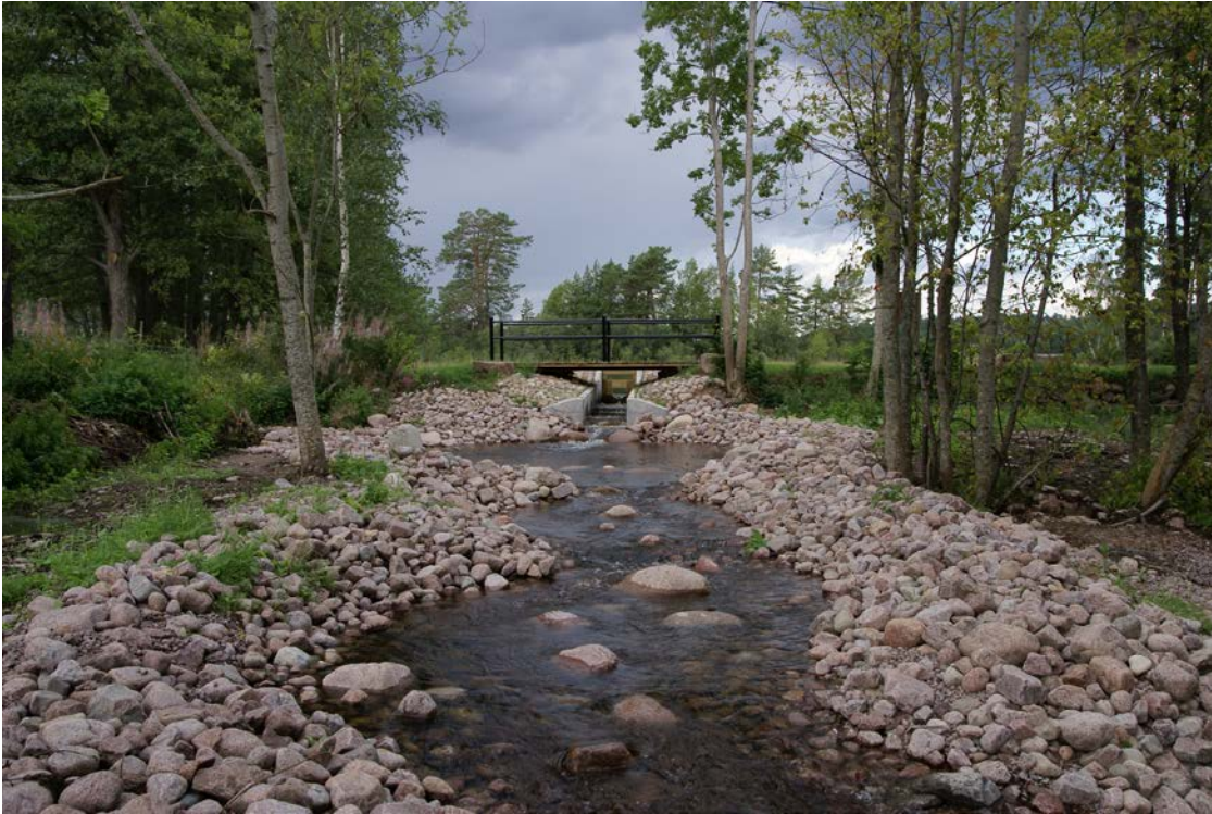
Omlöpet vid dammen. Foto: Urban Hjalte
