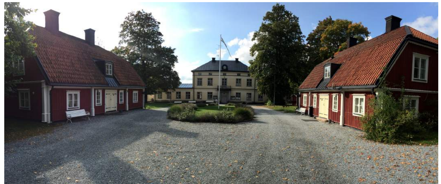
Riddersviks gård med mangårdsbyggnad och flyglar.
