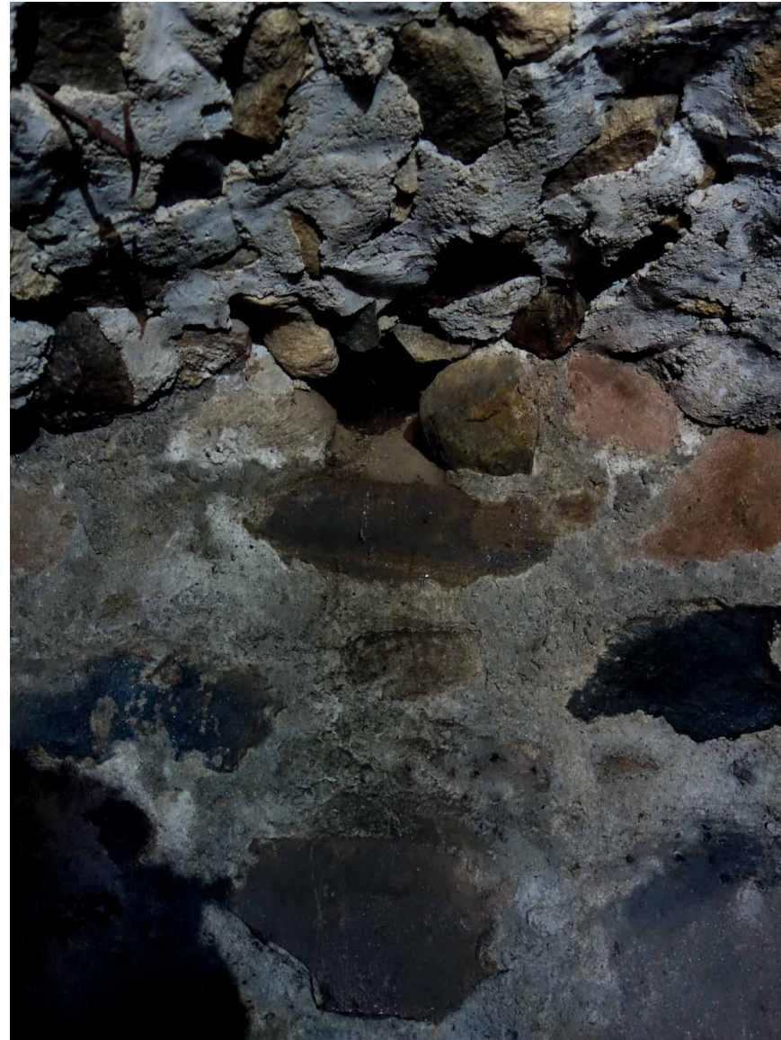
Betonggjutning på källarens tak och vägg. (Fredriksson arkitektkontor).
