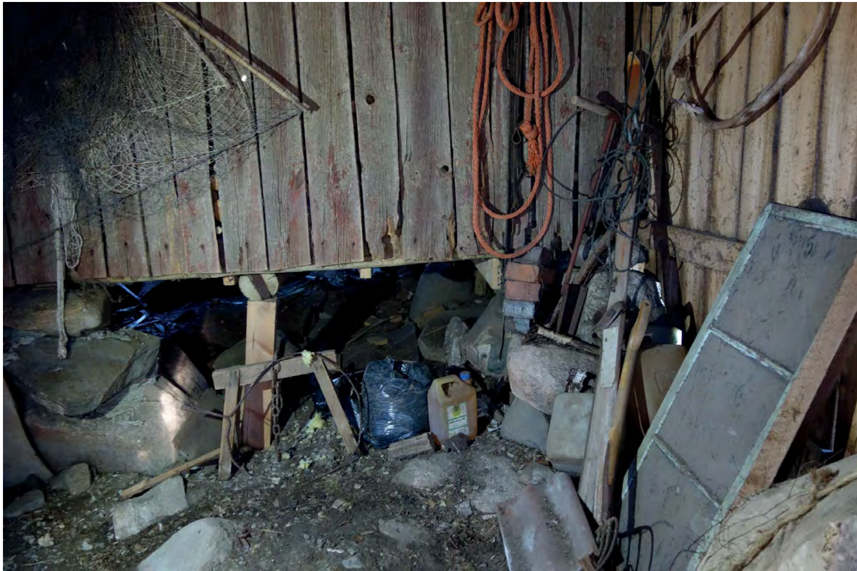
Garagets interiör. (Fredriksson arkitektkontor).
