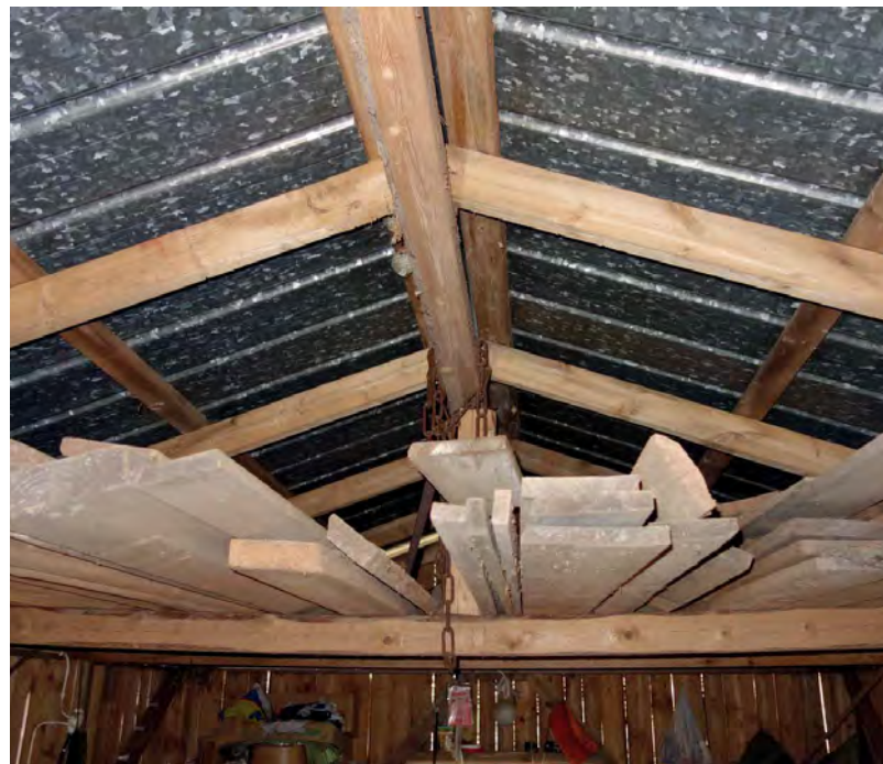
Garaget invändigt; gamla återbrukade bågar och undersidan av yttertakets galvaniserade pannplåt. (Fredriksson arkitektkontor).
