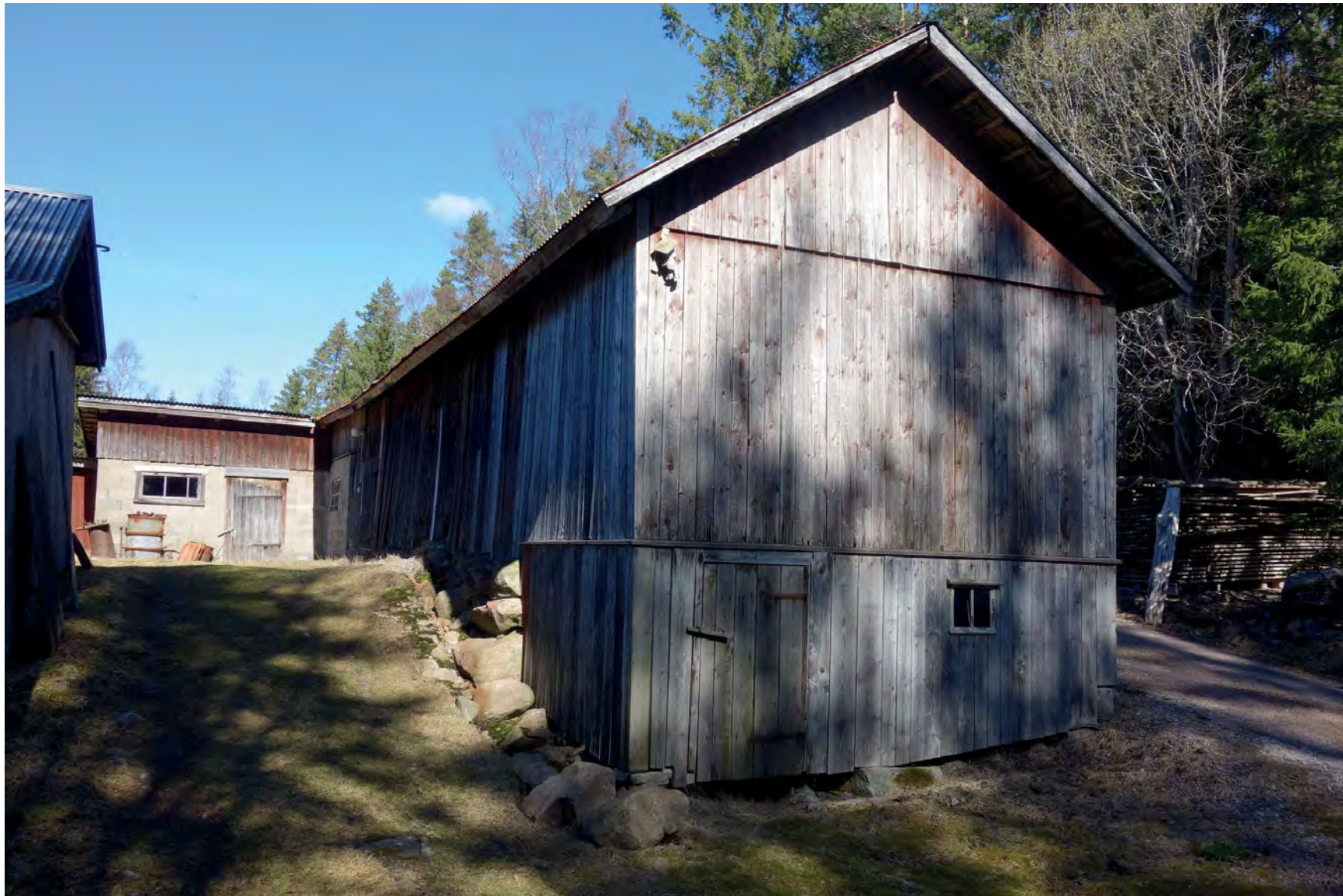
Byggnaden sedd från söder med sutterängplanet i förgrund. Gavelfasaden ändrades 2016. I bakgrund till vänster syns betongdelen. (Fredriksson arkitektkontor).
