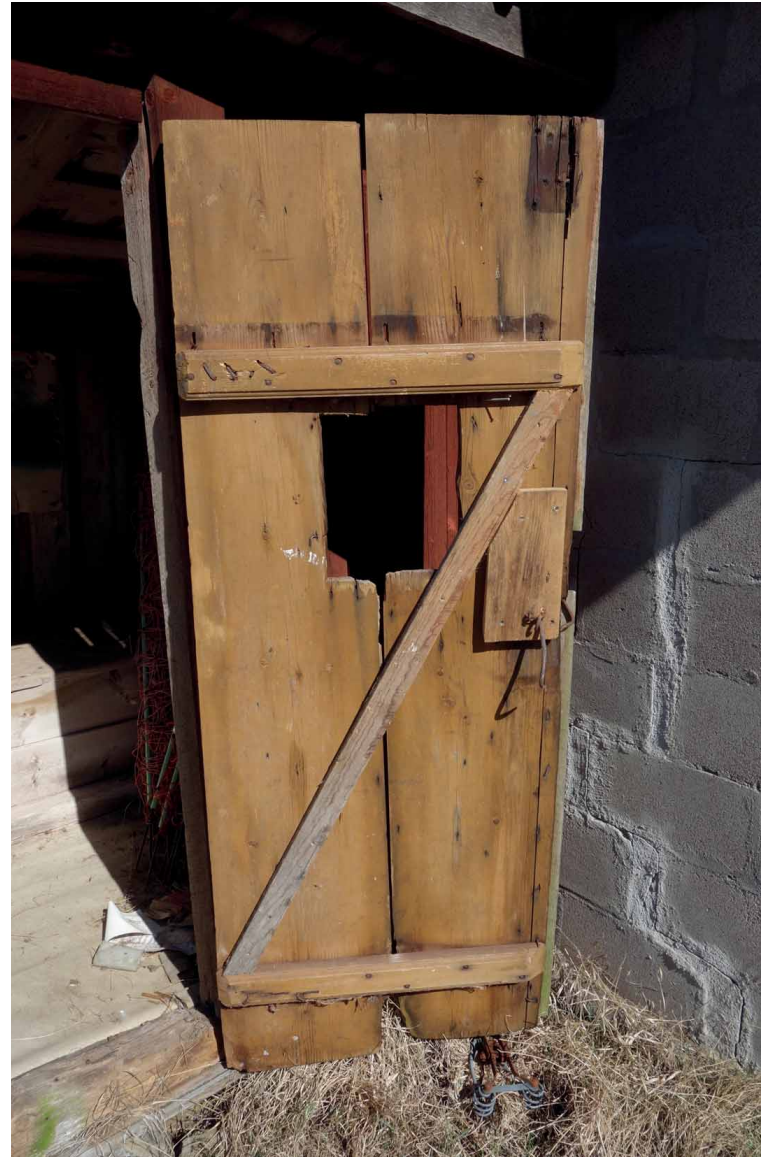
Dassdörren av hög ålder dess utformning och påkostade snickeri visar att den tydligt är återbrukad, sannolikt från det äldre bostadshuset. (Fredriksson arkitektkontor).
