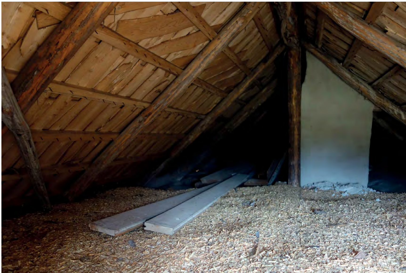
Vindsutrymmet på Brygghuset i gott skick. (Fredriksson arkitektkontor).
