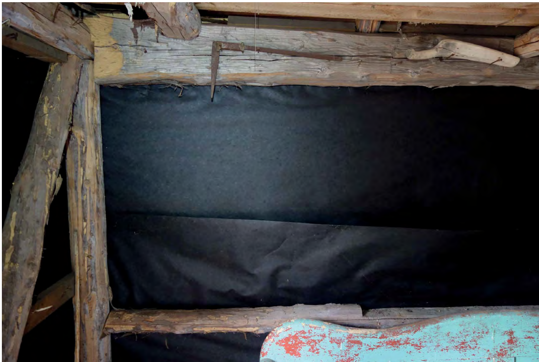
Vindpapp från 2016 i brygghusets förrum med fula skarvar. (Fredriksson arkitektkontor).
