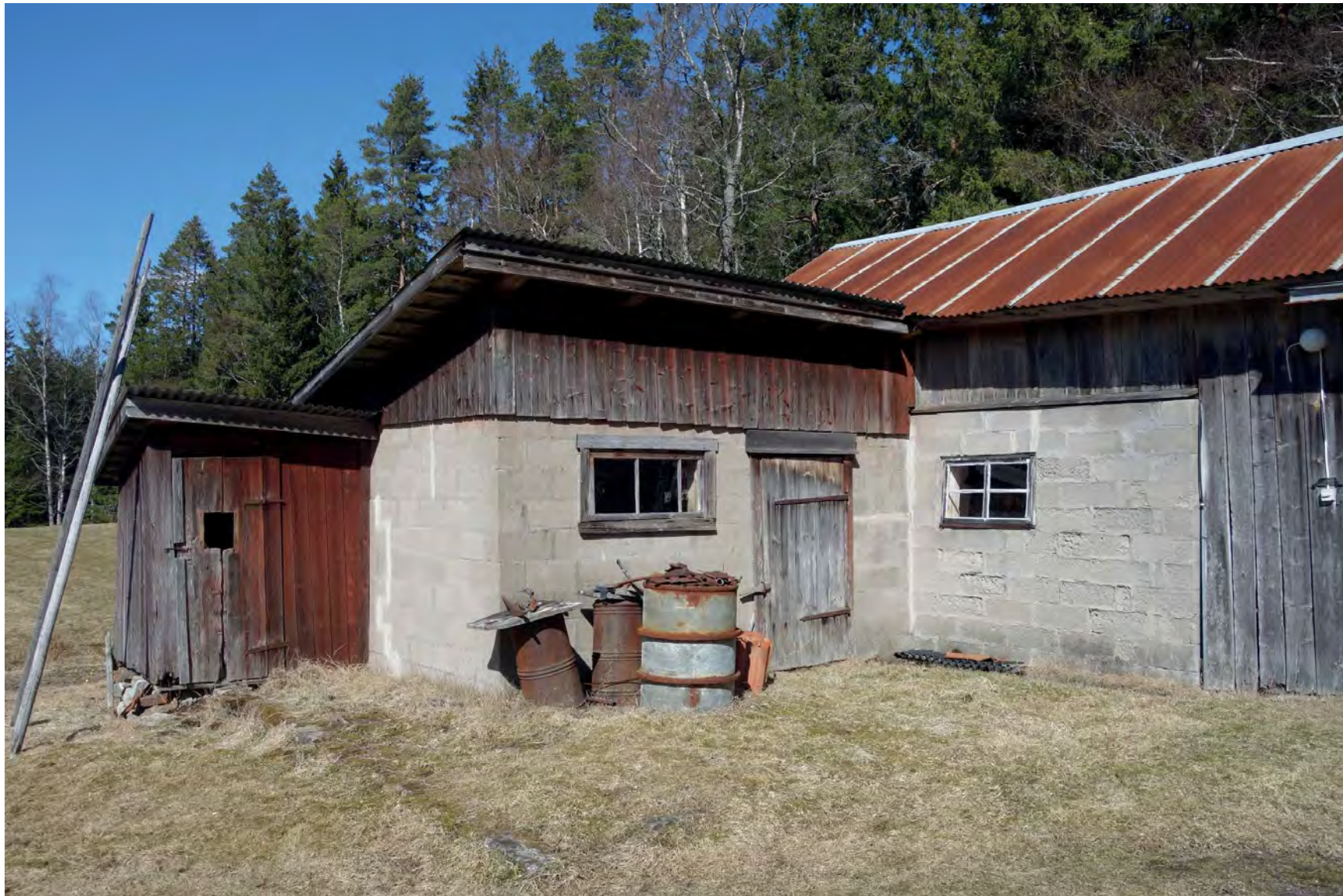
De två betongdelarna i norr samt dasset till vänster. (Fredriksson arkitektkontor).
