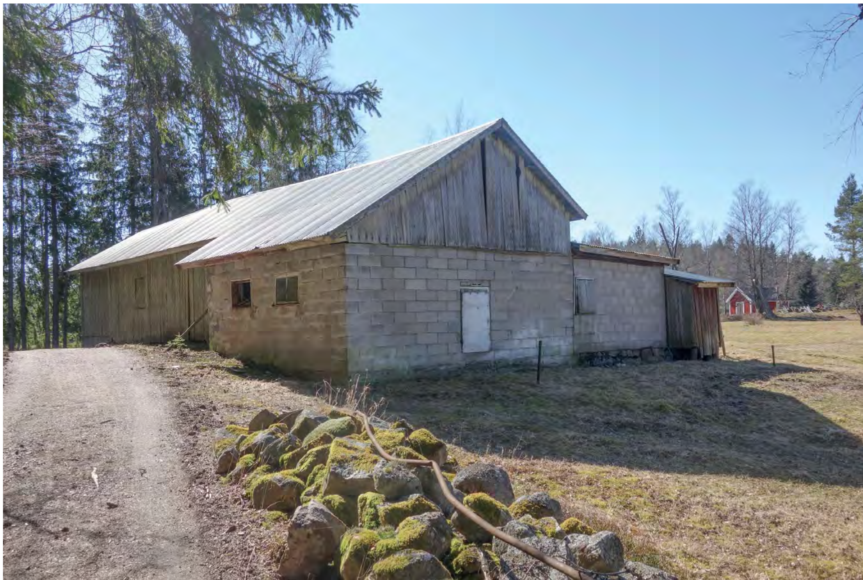
Byggnaden sedd från nordväst. Här syns den norra betongdelen med sina två byggnadskroppar som sitter ihop. (Fredriksson arkitektkontor).
