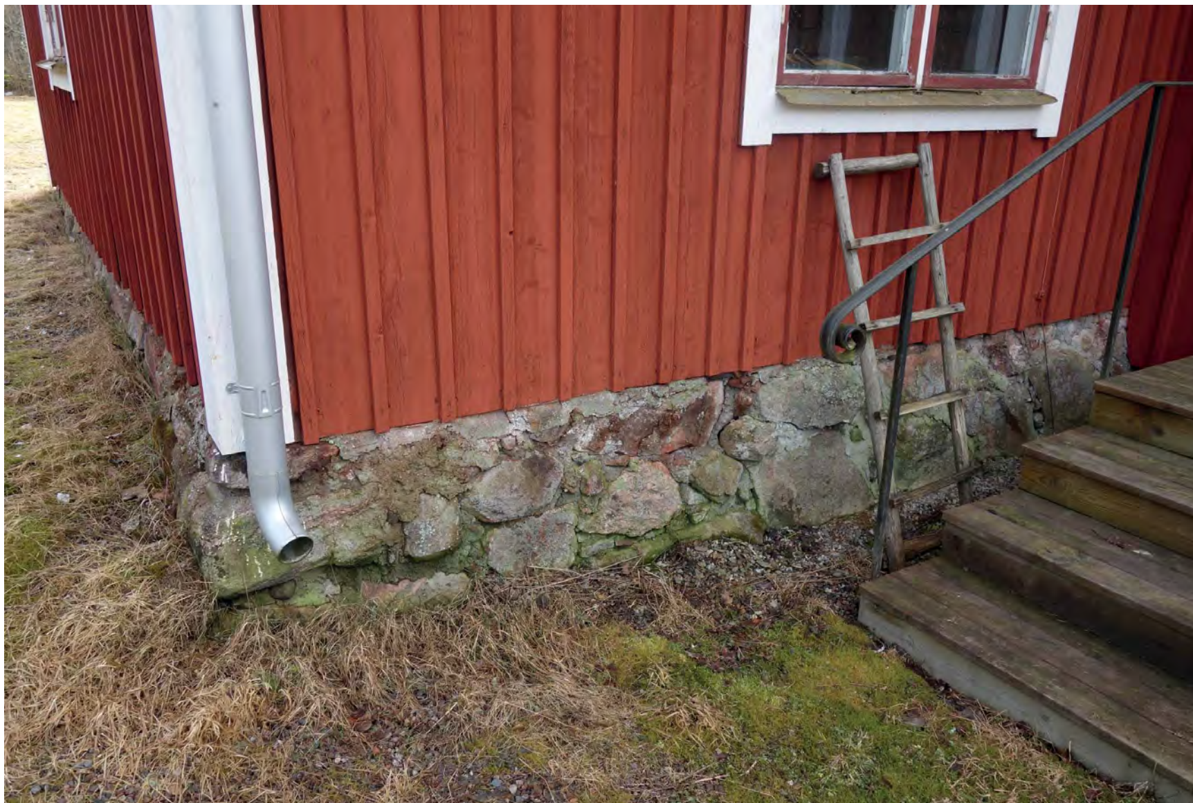
Norra grunden av sten med kompletteringar av betong (Fredriksson arkitektkontor).
