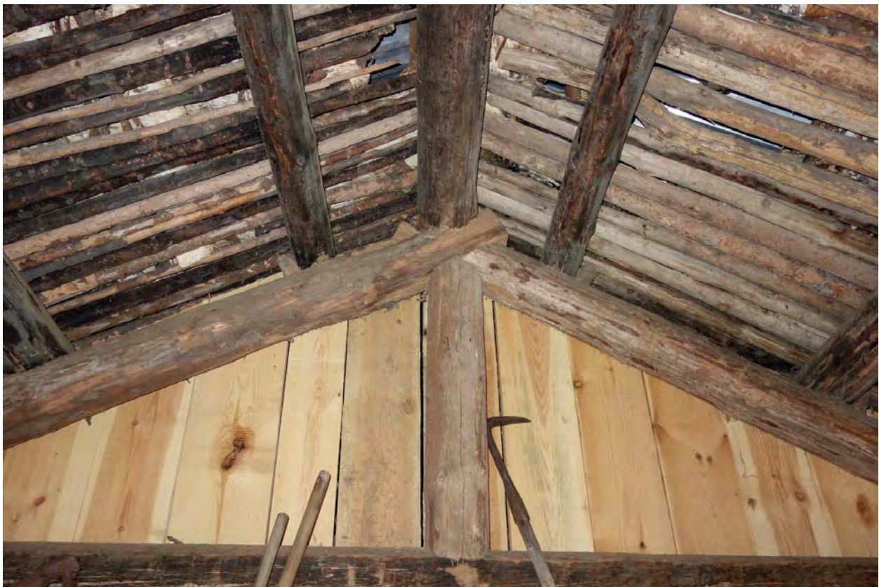
Underlagstak av störrar och näver (Fredriksson arkitektkontor).
