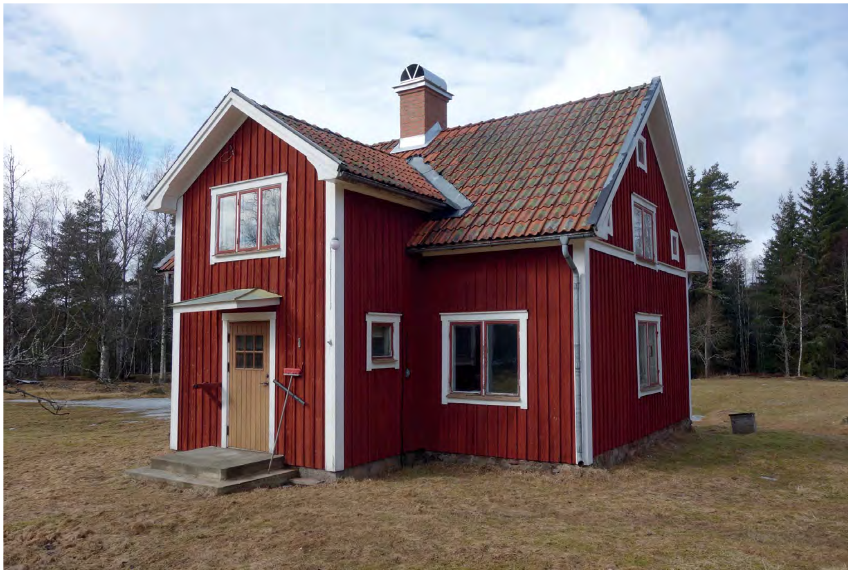
Vy av bostadshuset från sydöst. Huvudentré med trapphusutbyggnad (Fredriksson arkitektkontor).
