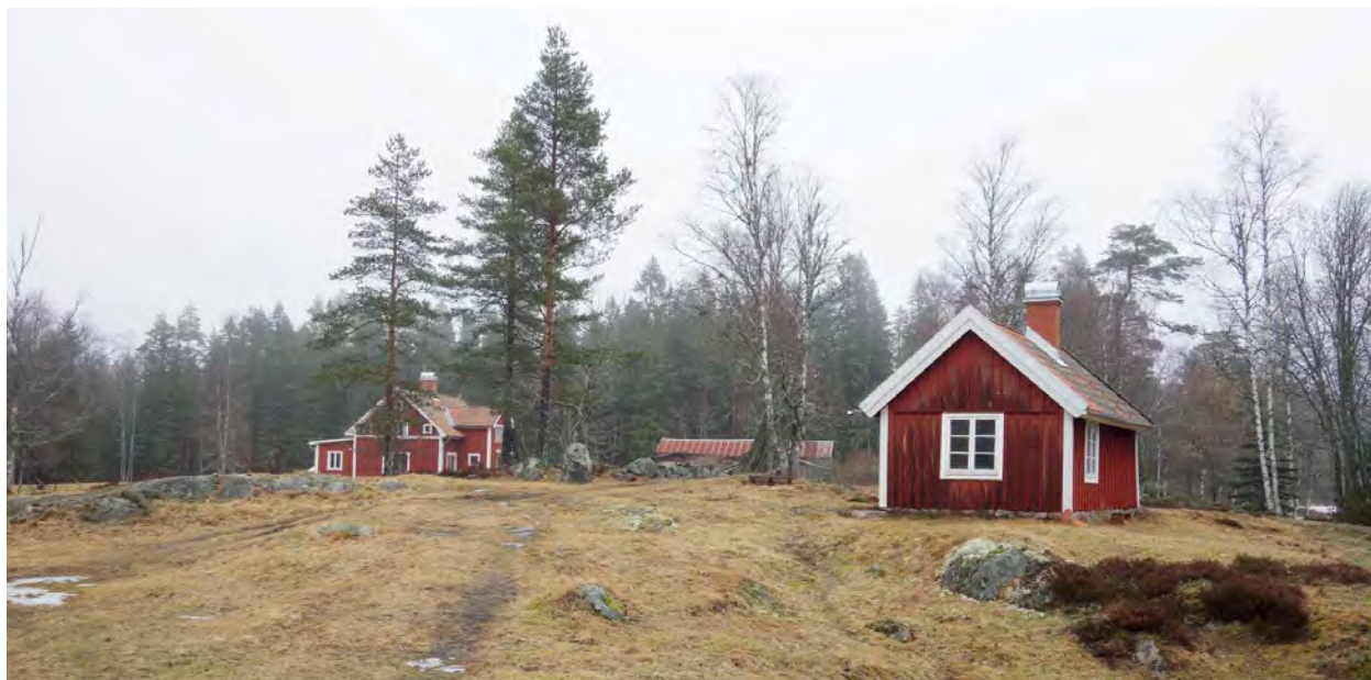
Hyttebackens gårdsbebyggelse från sydväst med brygghuset i förgrunden (Fredriksson arkitektkontor).
