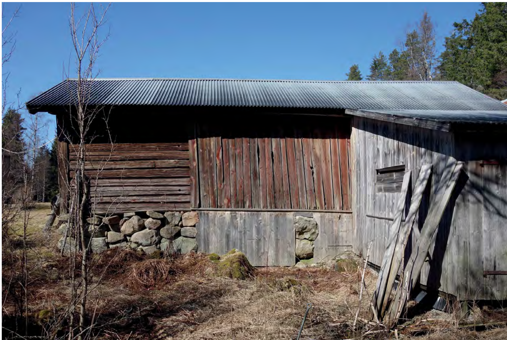
Södra fasaden. Inbrädning under byggnaden utförd 2016. (Fredriksson arkitektkontor).
