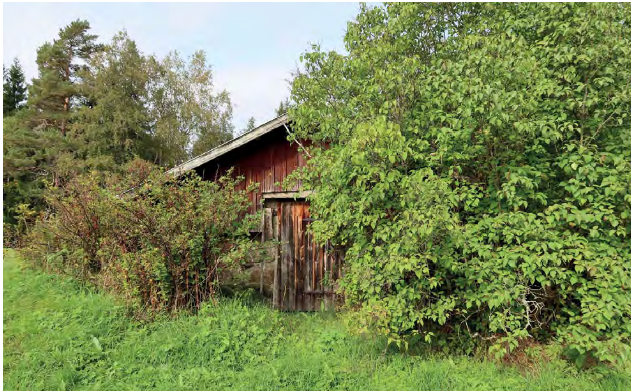
Jordkällarens framsida, med vinbärbuskar till vänster och syren till höger om entrén. Foto: Nivå.
