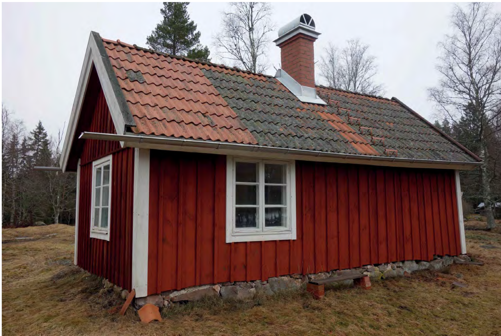
Brygghuset med långsida mot söder och gavel åt väst (Fredriksson arkitektkontor).
