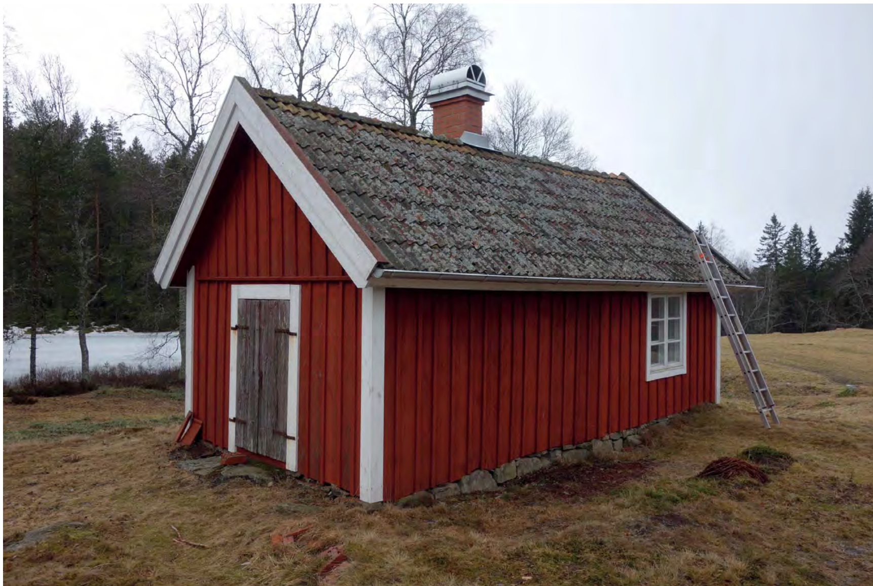
Brygghuset med gavelentré åt öst och långsida åt norr. (Fredriksson arkitektkontor).
