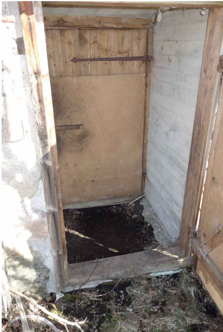
Jordkällarens svale. (Fredriksson arkitektkontor).
