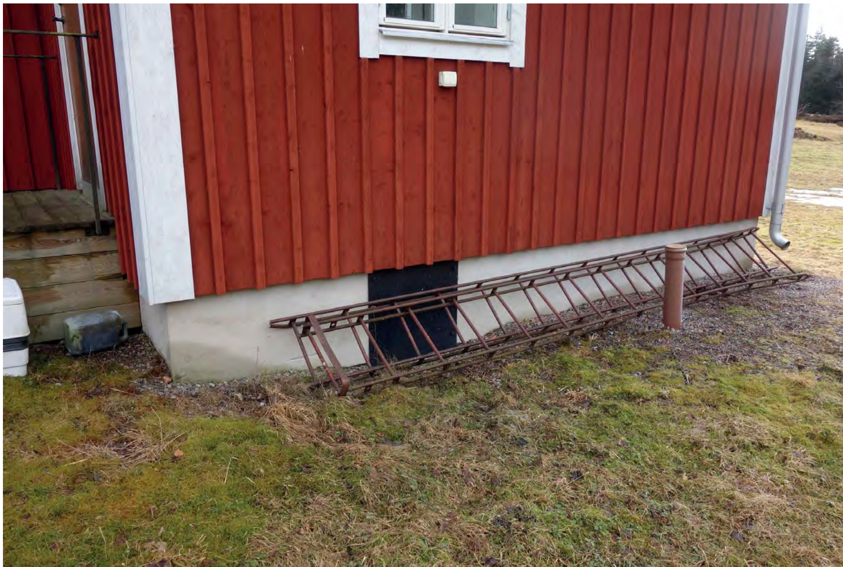
Norra utbyggnaden från 2016. Utbyggnad på grund av skivmaterial som putsats (Fredriksson arkitektkontor).
