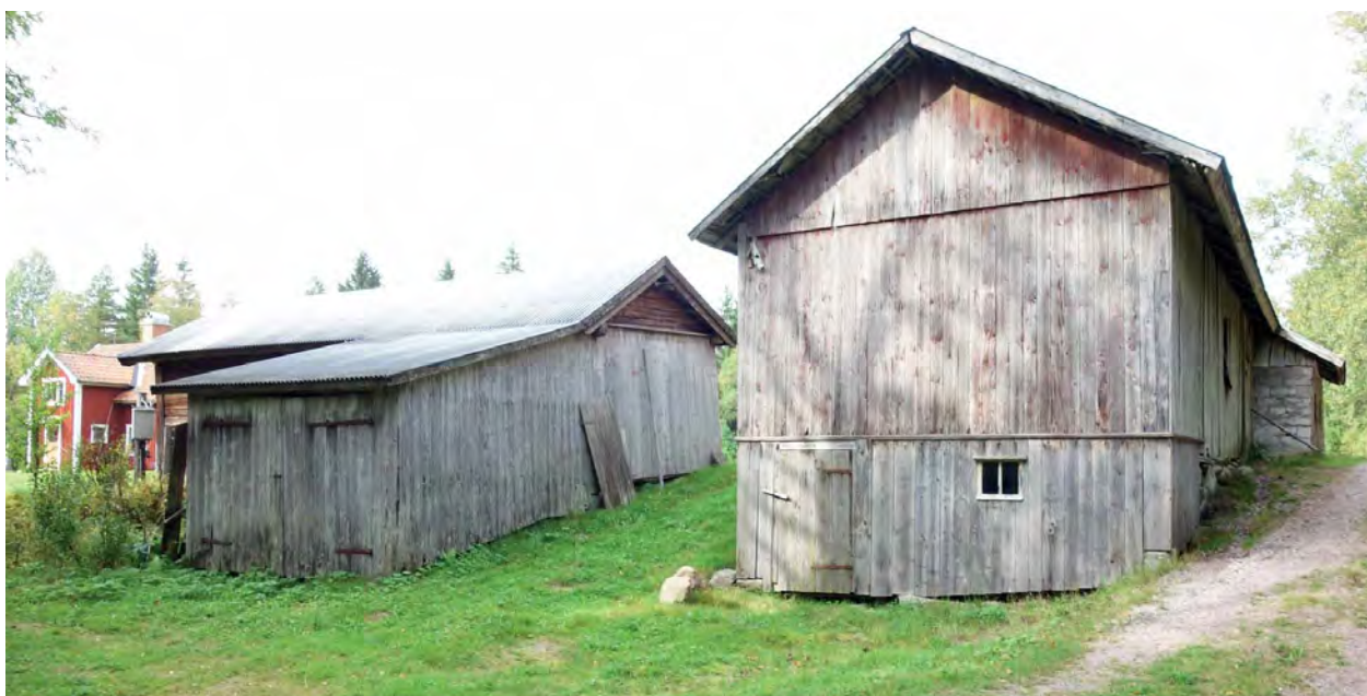
Ladugård och förrådsbyggnad med tillbyggt traktorgarage från sydöst. Till vänster i bild skimtar det rödfärgade bostadshuset. Längst till höger i bild sticker ladugårdens betongmurade tillbyggnad ut (Fredriksson arkitektkontor).
