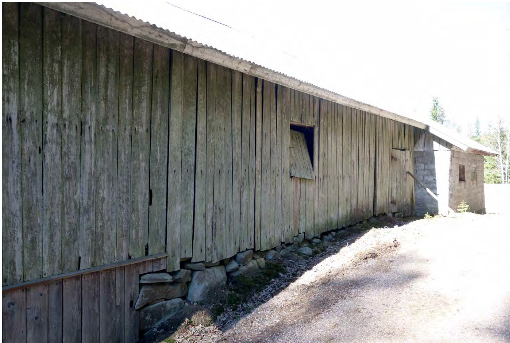
Östra fasaden med slät, kilsågad panel. I mitten av bilden syns luckan som använts som öppning för tröskverket. (Fredriksson arkitektkontor).
