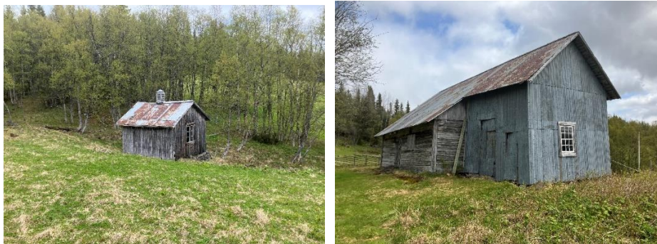
Tvättstuga och ladugård vid Valltorpet. Plåten i väggarna på ladugården är återanvänd och kommer från en Magasinsbyggnad som revs omkring 1920.
