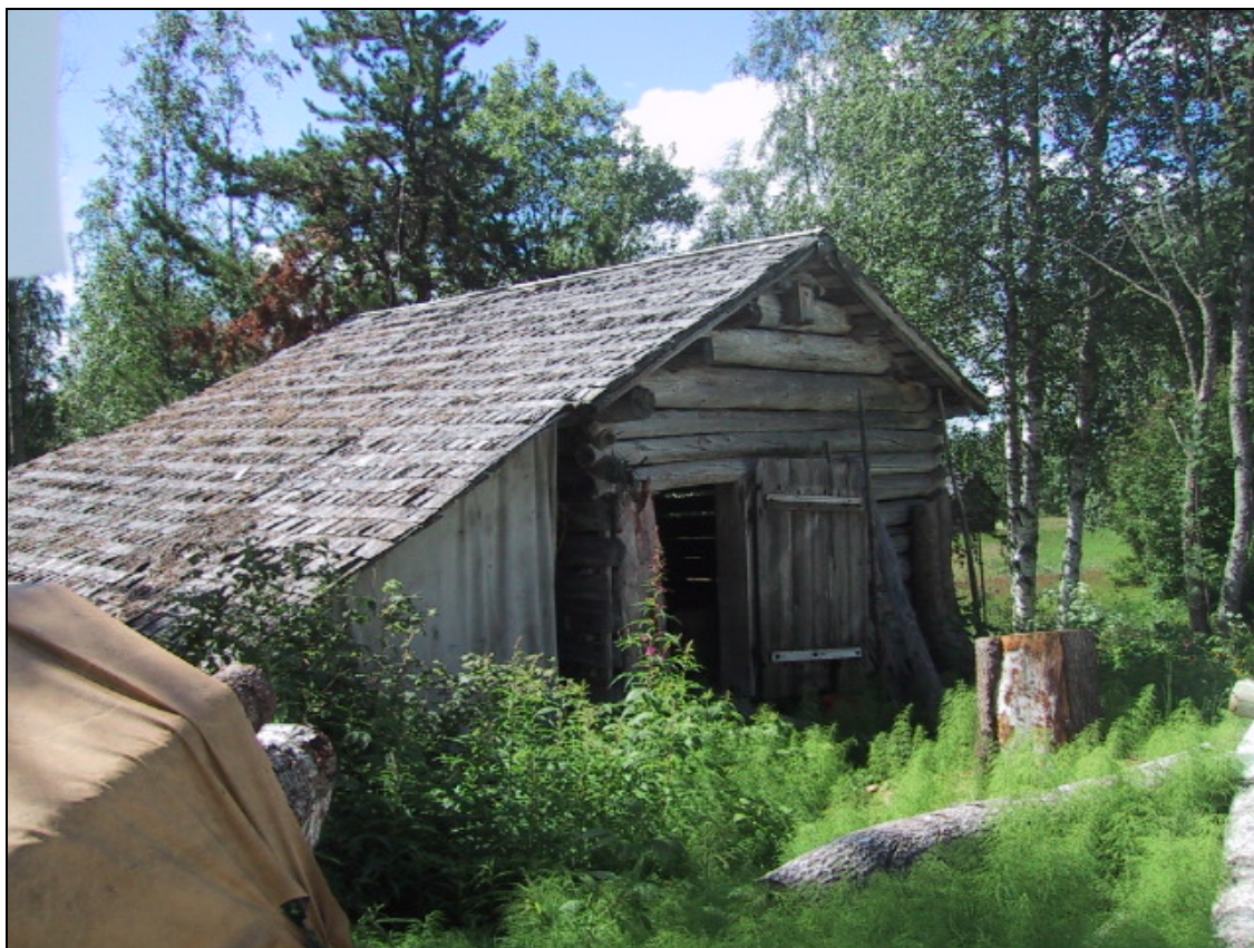
Spåntak lagt i omlott omväxlande från höger och vänster, vilket ger en mönstereffekt. Byggnad nr 54.
