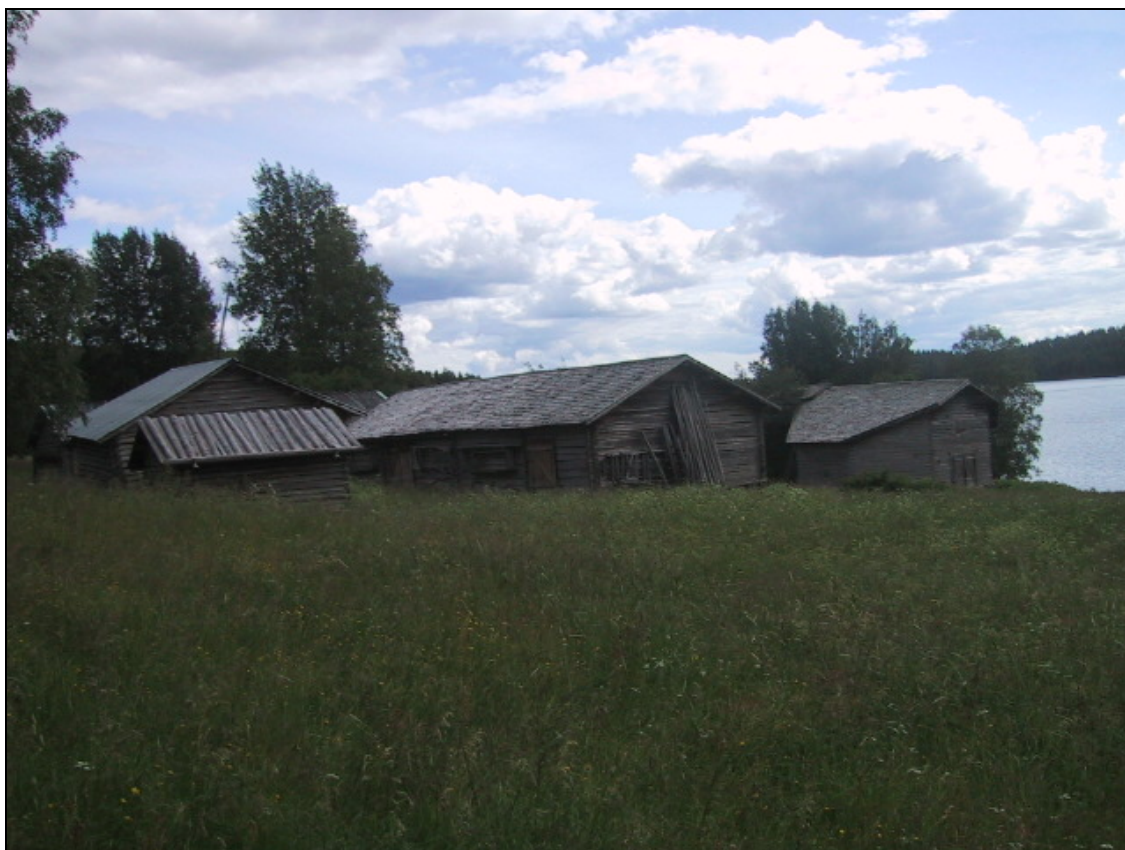
Uthus på Anders-Larsagården. Till vänster ladorna nr 11 och 12. I mitten stallet nr 13 och längst till höger rundlogen nr 30.
