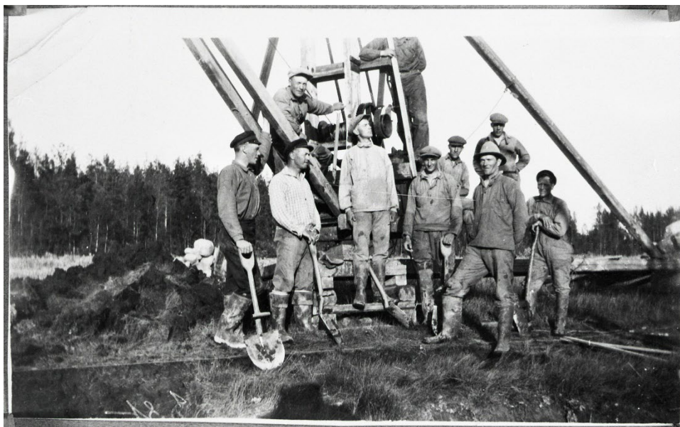
Dike grävs vid Harrsjön 1934. Fotograf Bo Nyström, Skellefteå museums samlingar SMJ 11623.
