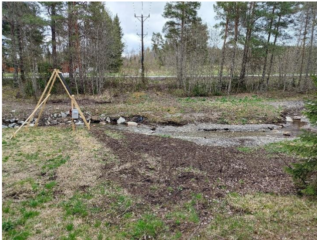
Figur 5. Skötselområde D: Det tidigare dammområdet som restaurerats till ett meandrande vattendrag.
