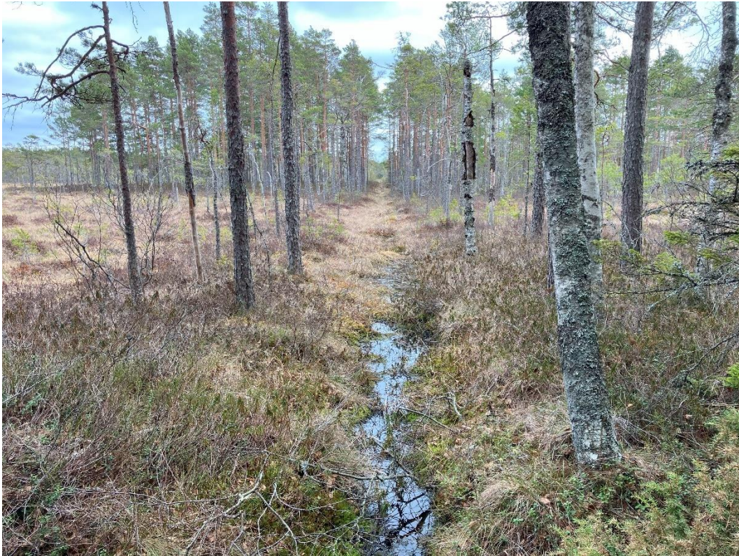
Figur 14. Ett av dikenena på Grottmossen som i dagsläget inte bedöms ha någon större markavvattnande effekt. Vid en annan bedömning finns fortfarande möjligheten att åtgärda diket genom igenläggning eller likande åtgärd.
