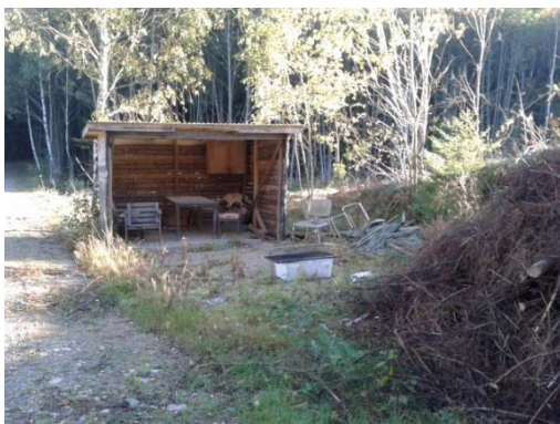
Figur 40 Vindskydd på Fastigheten Norra Pårup 1:1 som står vid X423838, Y6205583 som bör tas bort eller även upplåtas till allmänheten
