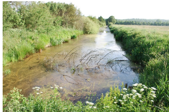
Diket i riktning mot norr från pumpstationen
