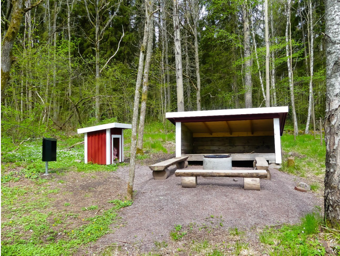
Figur 22. Det gamla vindskyddet med grill har fått en helrenovering.
