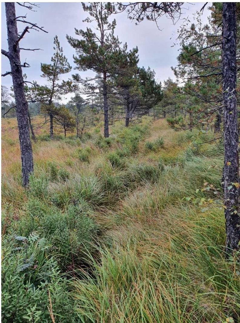
Figur 7. Avvattnande dike, cirka 1,5 meter brett och 1,5 meter djupt, som löper från Kråketjärnet till Lilla Gåsevattnet. Fotot visar dikessträckan i väster där diket löper genom öppen myr. Här finns en kraftig trädridå av tall.
