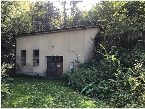
Figur 43 Turbinhuset vid Mjölmsjön
