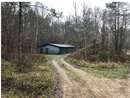
Figur 45 Tidigare mobiliseringsförråd, revs år 2022
