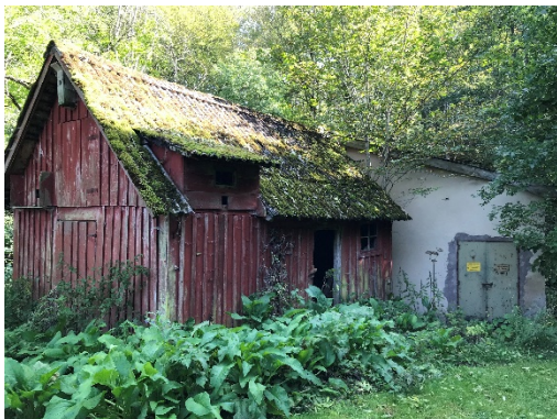
Figur 44 Två ekonomibyggnader vid Mjölmsjön
