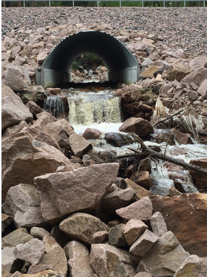
Foto 5. Valvbågen med det fall som bildats efter åtgärd. Fotot är taget 2016 av Trafikverket.
