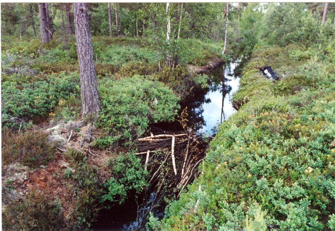
Dike med bäverdämme öster om Vikängen ("Vikängendiket"). Diket är här relativt nyligen rensat. Området ovan dämmet är kraftigt försumpat.
