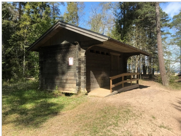
Figur 13. Servicebyggnad vid stigen till Sandbankarna.
