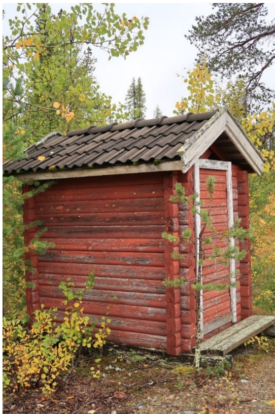
Bild 3. Befintligt utedass i anslutning till kojan vid Lundsjön. Foto: Länsstyrelsen Norrbotten
