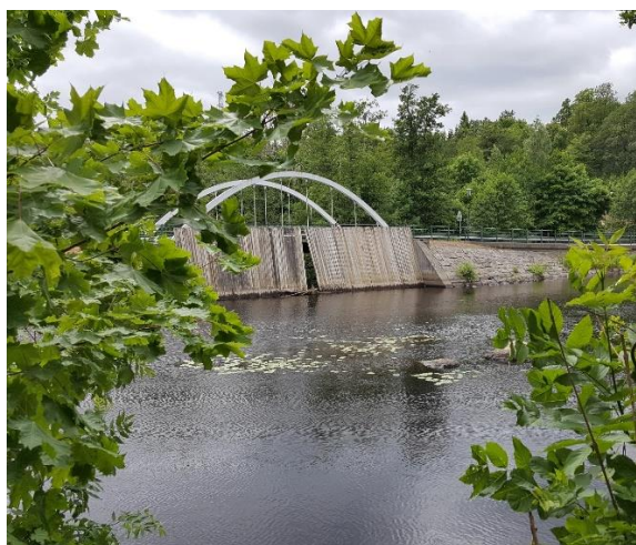
Figur 6 och 7. "Nålarna" vid Ebbamålas dämme, stängda respektive öppna (Foto: E. Wallsten, juni 2018 och mars 2020).
