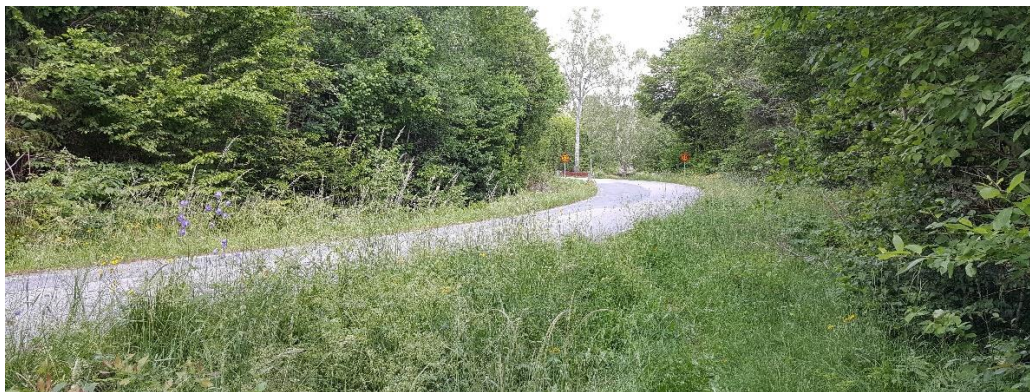
Figur 42. Kurvan vid Hovmansbygdsvägen (Foto: E. Wallsten, juni 2020).
