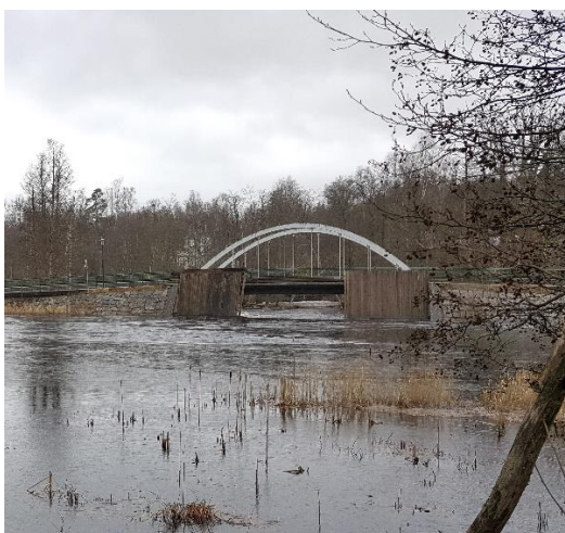
Figur 6 och 7. "Nålarna" vid Ebbamålas dämme, stängda respektive öppna (Foto: E. Wallsten, juni 2018 och mars 2020).
