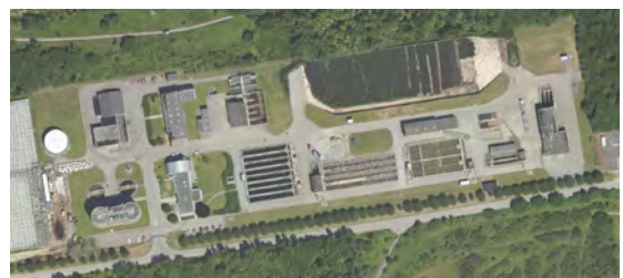
Klagshamns reningsverk, sett från ovan.
