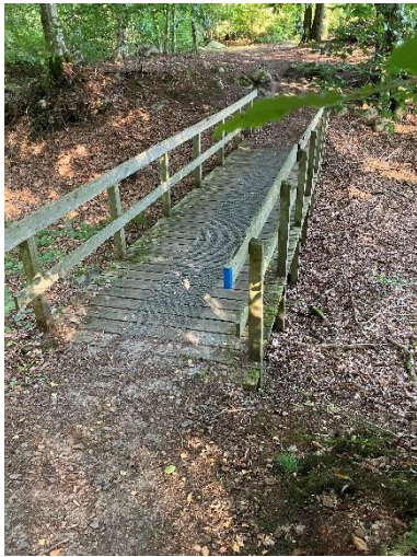
Figur 29 Bro över tidigare förmodat utlopp från Ormapumpen
