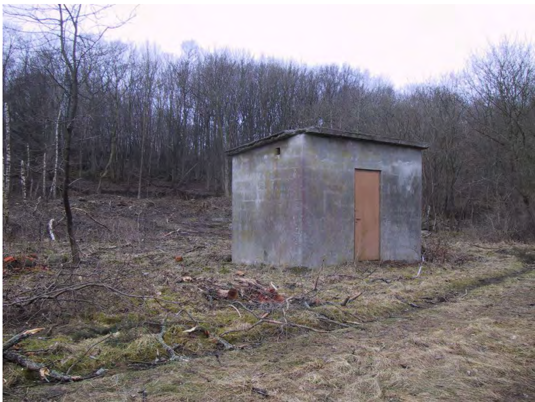
Betongbyggnad i skötselområde 1B i riktning mot sydväst.
