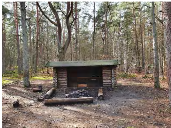
Befintliga vindskydd som ska underhållas.
