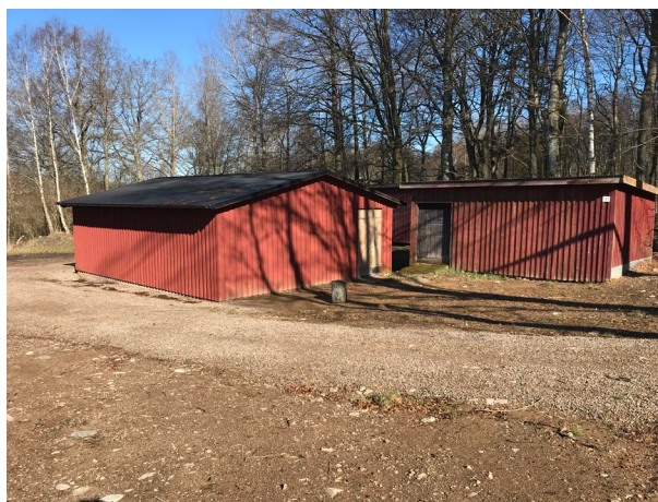
Förrådsbyggnader som kommer nyttjas av förvaltningen av naturreservatet
