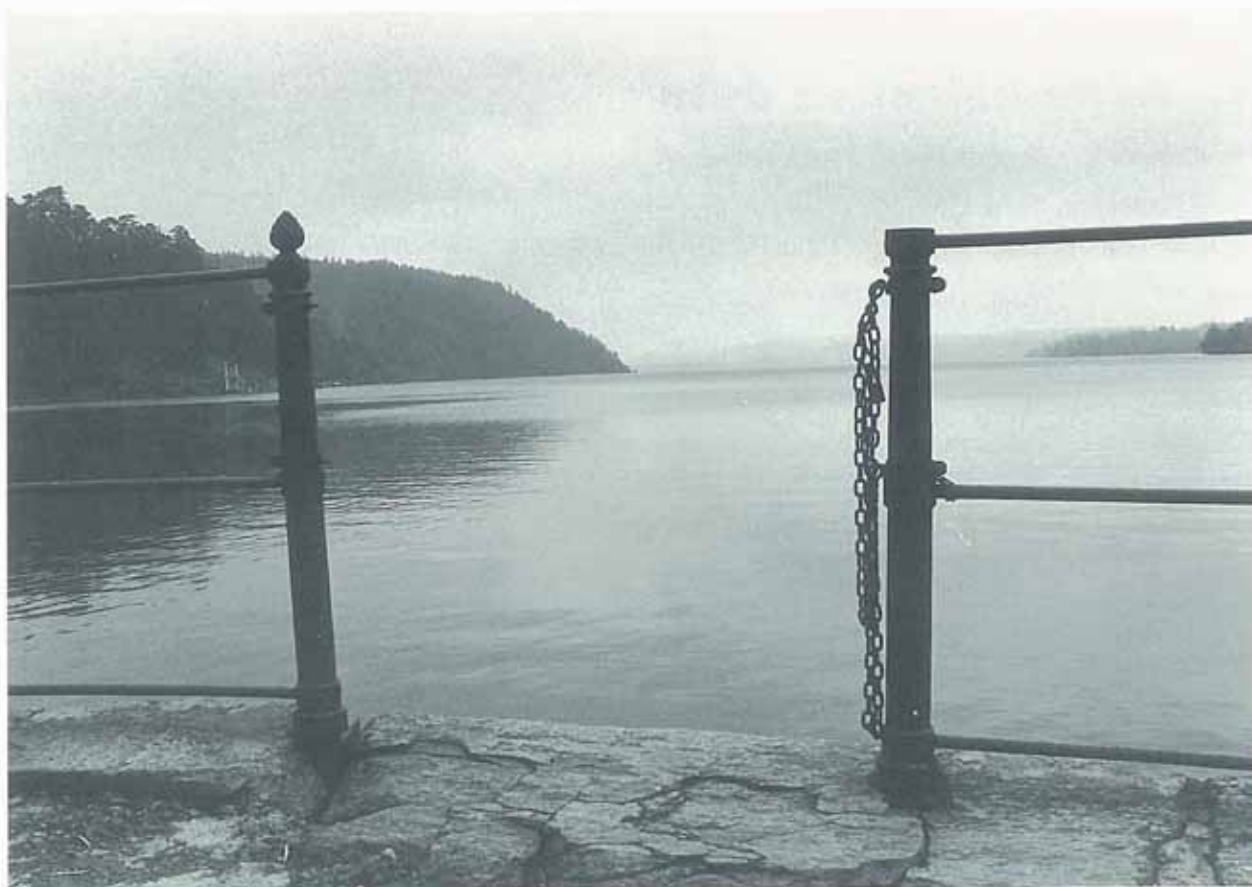
Yttre delen av kajen i Aspen nedanför Herrgården. Järnräcket är fullt av konstrika detaljer som också återfinns på motsvarande räcken i fabriksområdet. (1985).
