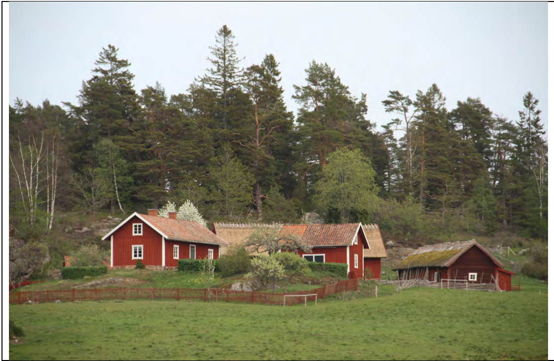
Gården Långmaren, vilken är ett byggnadsminne. Foto Stephan Gäfvert.
