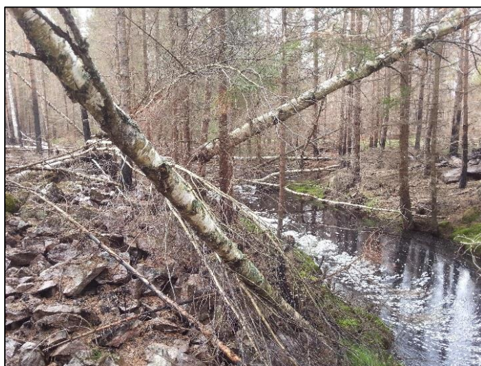
En av två sprängda bergsklackar som en gång i tiden bidragit till att hålla vattenmassorna på hög nivå i Orrängarna-Hjortronmossen och som relativt enkelt kan återställas.
