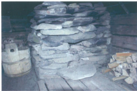
Rökugnen sett framifrån, med eldningshål och rakt valv. Att ugnen murats om syns bland annat på stenarnas ojämnt sotiga ytor. Värmlands Museum, Monica Björklund.
