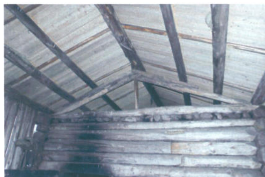
Bastuns tak sett från insidan. Utbordskroken som löper frånnock till hammarband syns mellan de ljusare panelbrädorna. Här syns också att intertaket löper ut.
