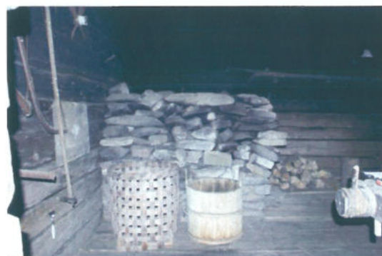
Bastuns ugn sett från bastuns entrédörr. Ugnens kallmurade långsida syns. Till vänster syns gluggen som släpper ut röken, stängd med en lucka. Foto: Värmlands Museum, Monica Björklund.
