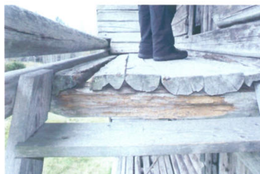
Stocken som håller loftet på plats har insektsskador. Bör bevakas så att den håller att gå på. Foto: Värmlands Museum, Monica Björklund.
