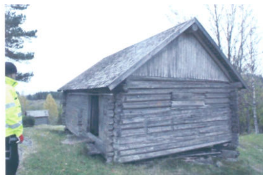
Logens östra och norra fasader. Igensatt öppning mot norr. Foto: Värmlands Museum, Monica Björklund.
