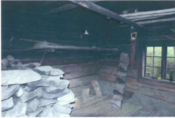
Bastuns högt placerade och något klena lave syns på bild. I bild också en stege tillverkad av en stock. Foto: Värmlands Museum, Monica Björklund.
