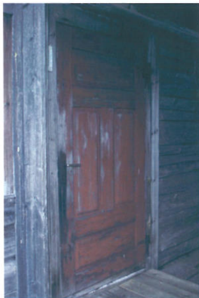
Spegeldörr vid köksingången, östra vindfånget. Foto: Värmlands Museum, Monica Björklund.
