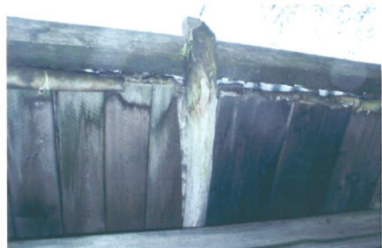
Detalj av takfot, men utbordsbräda och utbordskrok. Näver mot kanten och den sinuskorrugerade plåten syns. Foto: Värmlands Museum, Monica Björklund.
