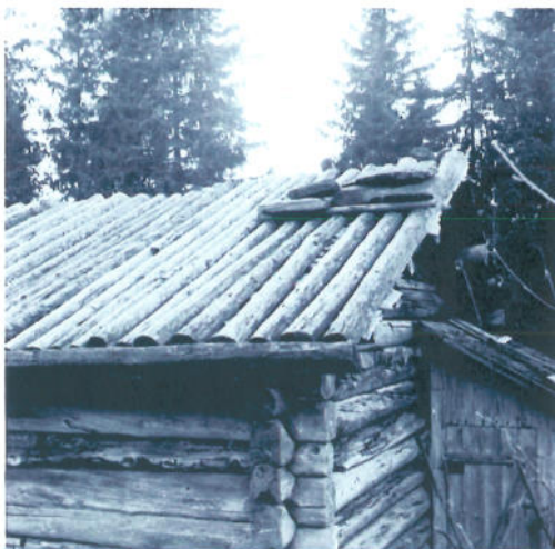
Detalj av täckjekrok på bastun vid Ritamäki, 1965. Bastuns innertak löper ut i gavelfasaden till höger. Foto: Värmlands Museum, Gösta von Schoultz.
