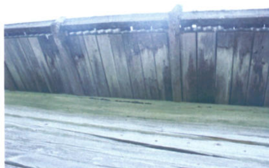
Detalj av takfot, med underbräddor, sinus-korrugerad plåt, utbordsbräda och utbordskrok. Foto Värmlands Museum, Monica Björklund.
