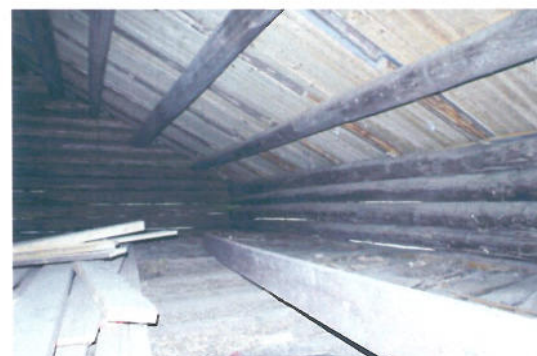
Ladugårdens höloft med yttertak sett från insidan. Utbordskroken har skarvats. Foto: Värmlands Museum, Monica Björklund.
