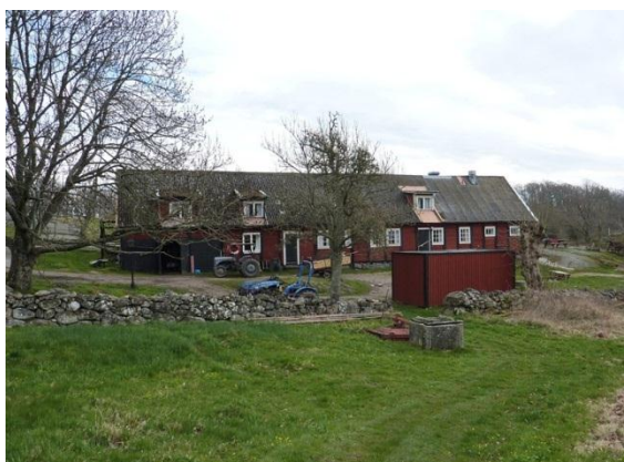
Ladugården (9) är uppförd i skiftesverk och ditflyttad från Åryd.
