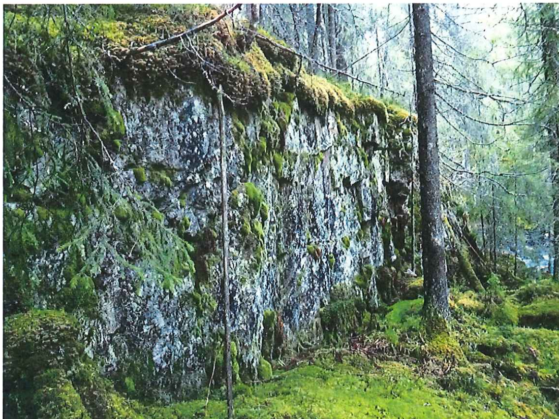
Lodvägg i anslutning till vattendraget
