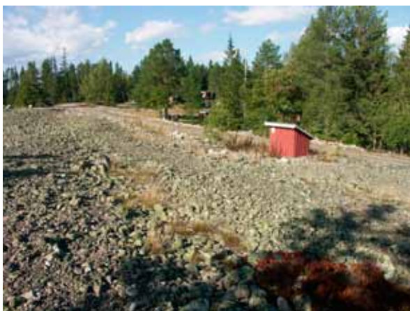
Parkeringsplats för att nå Laxskärsudden anläggs intill ett litet pumphus vid befintlig väg.
