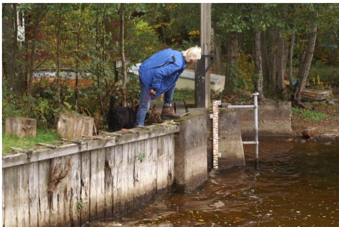
6d) Dammen vid Ågelsjöns utlopp (före den 160 m långa tilloppskanalen fram till kraftverkets damm). Denna damm ligger inom naturreservatet.
