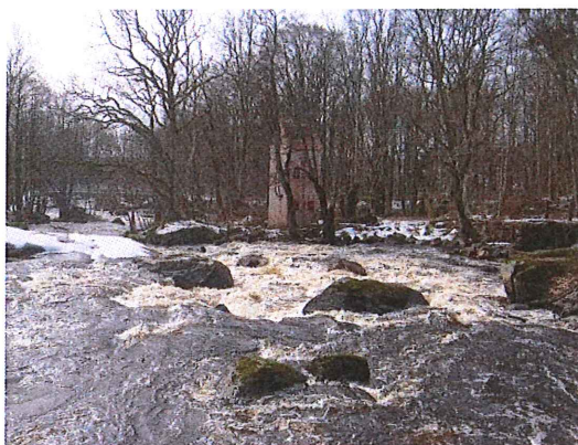
Figur 9. Renoverat transformatorstorn vid fd bruket.
