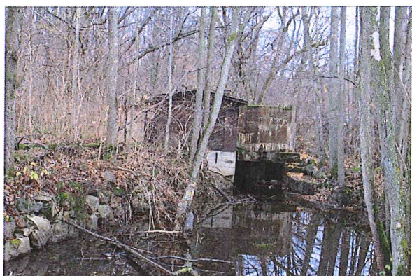
Figur 8. Fd generatorhus vid södra kvarnplatsen.
