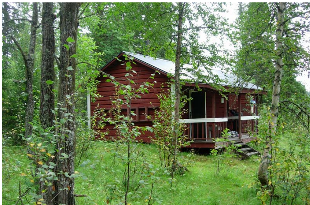
Bild 1. Höjdakojan är i bra skick och ligger mellan Västra- och Östra Stenbitssjön. Försiktiga röjningar ska genomföras intill byggnaden för att skapa sikt mot sjöarna.
