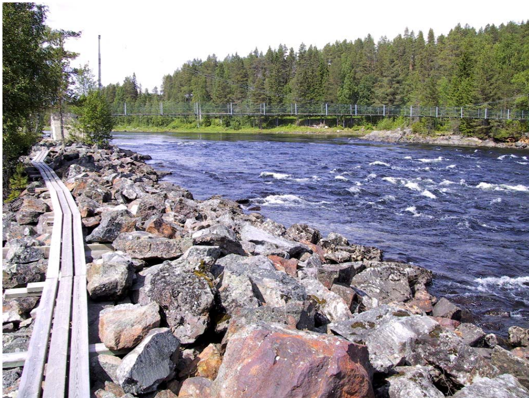
Foto: Efter att ha passerat de två första hängbroarna inom reservatet följer en delvis spångad led med vanliga träbroar över de återstående forsarna.
