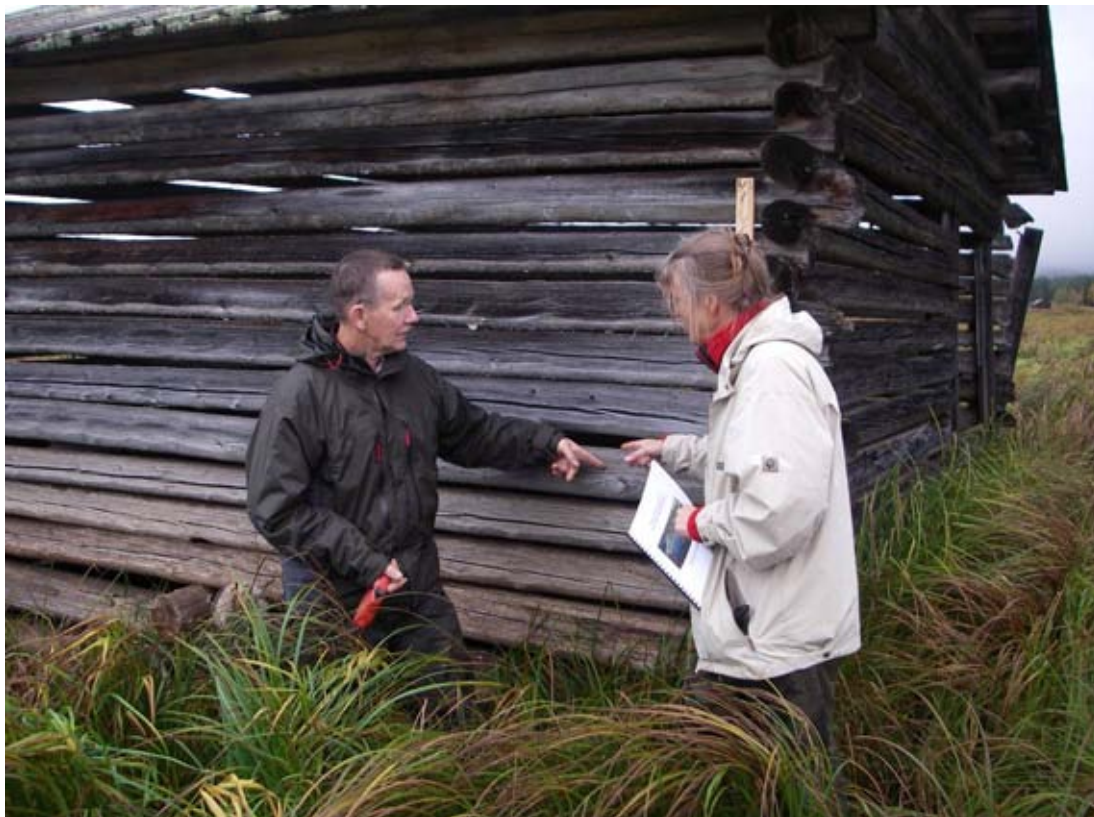
Bild 3. Ladorna ska i möjligaste mån bevaras och restaureringen ska ske på ett kulturhistoriskt riktigt sätt. (foto Tomas Staafjord)
