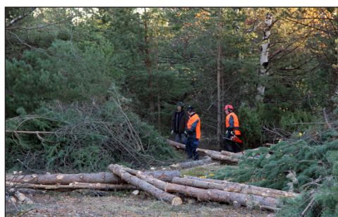
Rottryckning av stubbar föregås av avverkning av träd.
