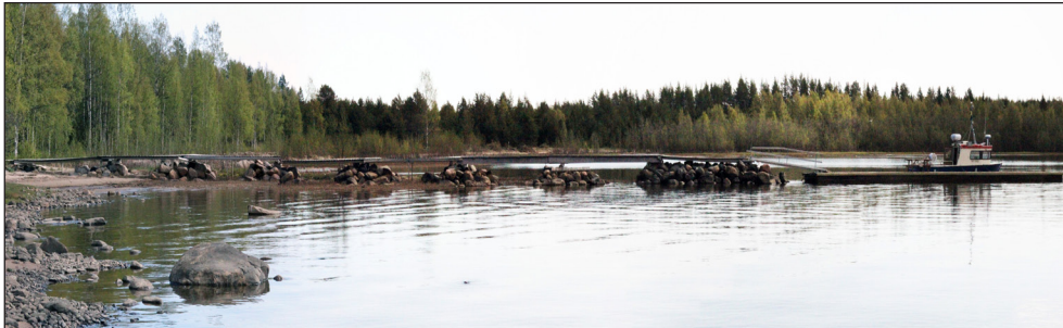
Sedimentation har medfört att vatten bara kan strömma fritt mellan de yttersta stenkistorna.
