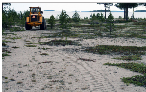
Rottryckning kan göras med hjullastare eller grävmaskin.
