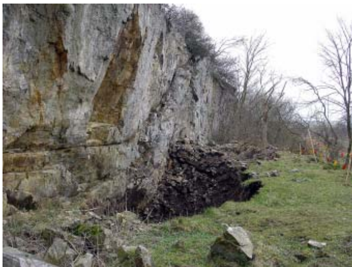
Planeringsområde 3. Instörtad gruvgång nedanför förkastningsbranten.
