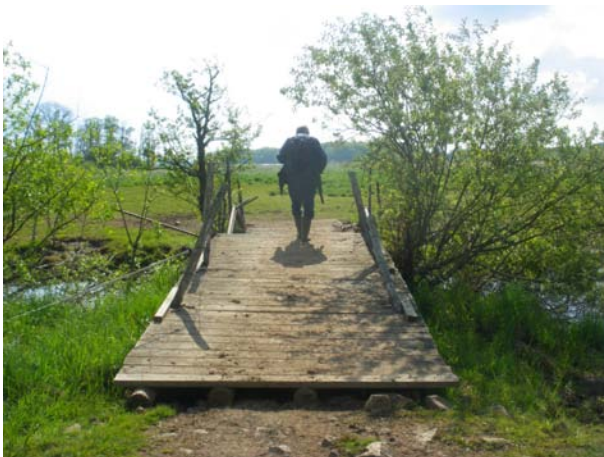
Befintlig kobro över Helgeåns ursprungliga fåra.
